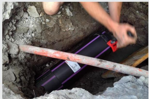
Bild 4: Montage der SIMONA® PE 100 CoEx schraubbaren Kurzrohrmodule mittels Gurtzange
