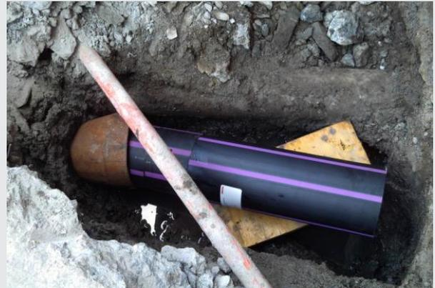
Bild 3: Einbau der SIMONA® PE 100 CoEx schraubbaren Kurzrohrmodule mit Spitzende in Zugrichtung
