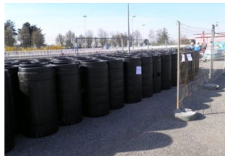
Moduły krótkich rur \text{śr} = 630 \times 37,4 mm na placu budowy przed instalacją
