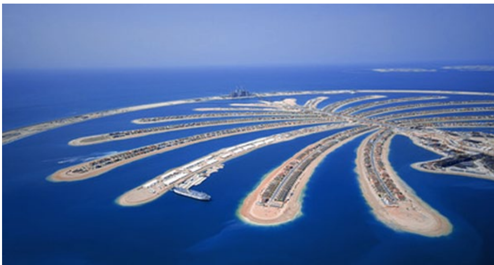
Osuszanie terenów morskich na przykładzie wysp w kształcie palm w Dubaju
