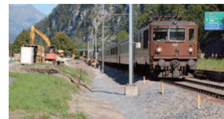
Plac budowy i skład rur obok przejezdnej trasy kolejowej
