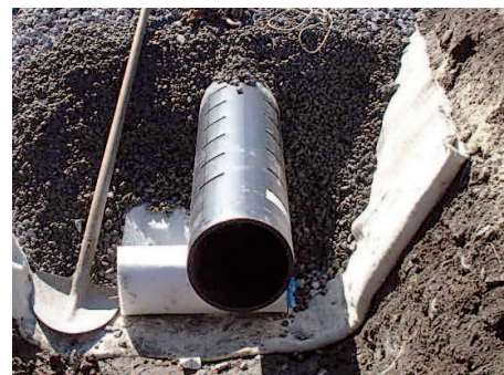
Otulina z geomembrany dla warstwy żwiru filtracyjnego
