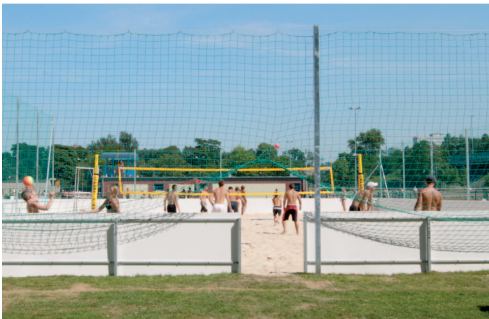
Boisko do siatkówki w trakcie gry. Do jego budowy użyto łącznie 110 płyt SIMONA® PE FOAM.
