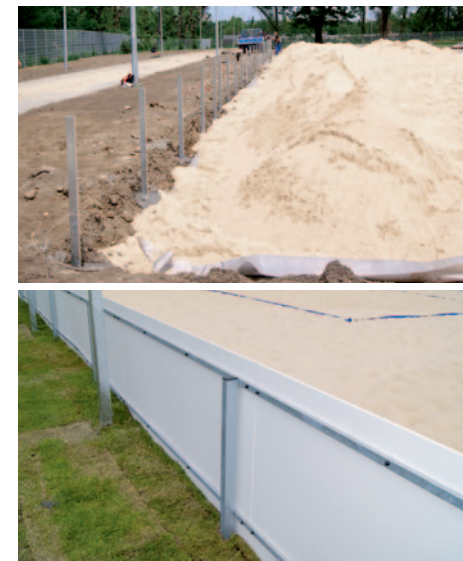
Od góry: Przygotowanie do montażu band Na dole: Gotowa konstrukcja
