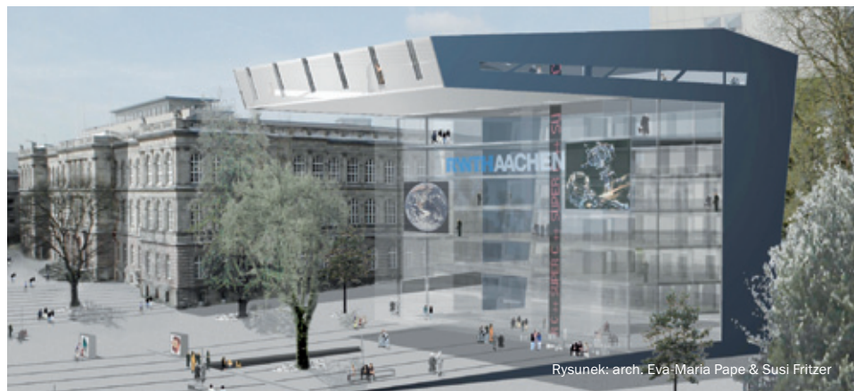
SIMONA® PP-H Alpha Plus® Geotherm do projektu geotermii głębinowej Politechniki RWTH w Akwizgranie.
